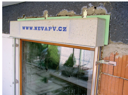
Montáž kastlíků na rekonstruované budově
